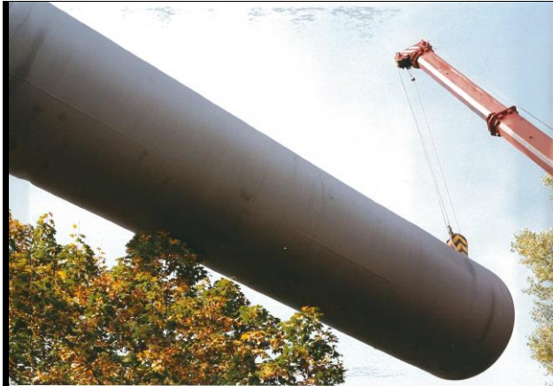
Bild 2/3: Transport und Installation 3.000 cbm Tankanlage der Linde AG auf dem Sattelplatz, Sept. 1995
